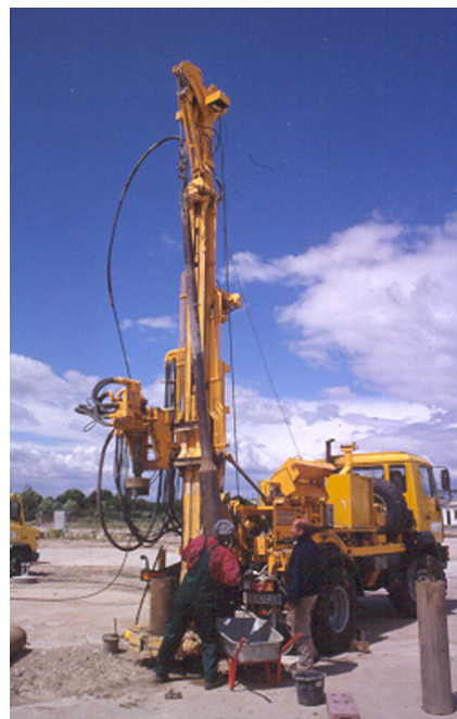
Abb. 5 : Durchführung von Bohrungen zur Aufnahme von Erdwärmesonden.
