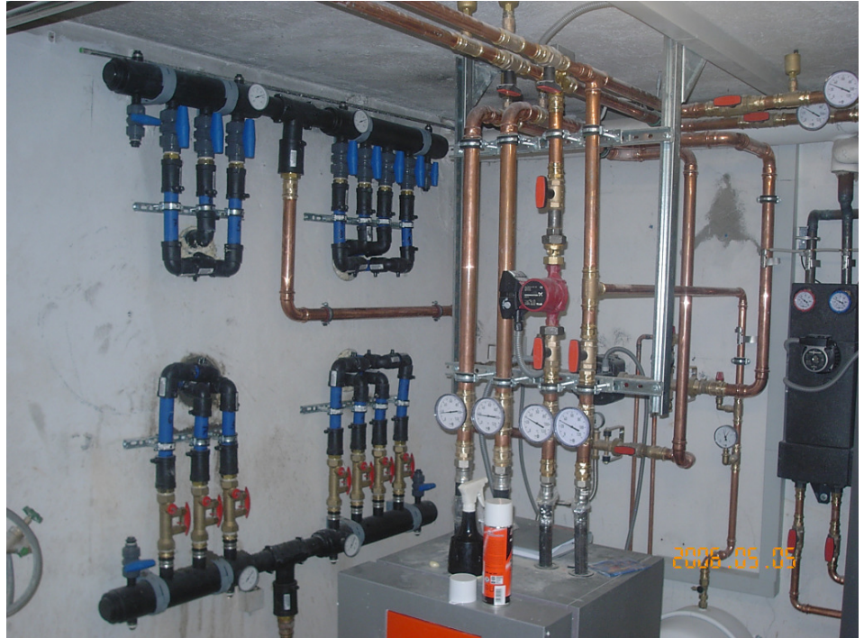
Abb. 8 (oben): Hausanschluss mit Verteil- system für Vor- und Rücklauf von 7 Erdwärmesonden.
